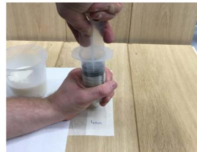
7. Injecter le mélange dans la cavité. Si nécessaire ajouter du produit en plus. Si nécessaire, lester les zones de la surface pendant env. 2 h
